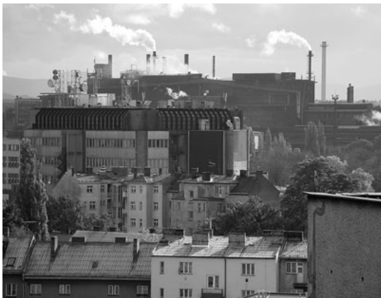
Vítkovická ocelárna č. 2, současný stav
